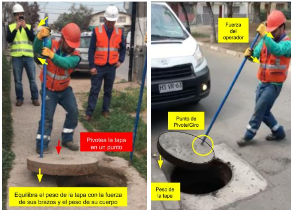
Movimiento de la tapa para apertura y cierre de la cámara
