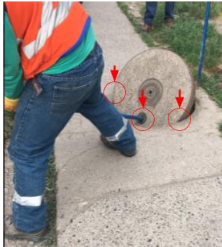
Puntos de contacto en los que se distribuye el peso de la tapa al ser descajada del agujero de la cámara (flechas en rojo)
