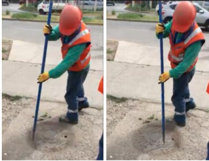
Trabajador golpeando tapa dúctil para “desagripar” la tapa
