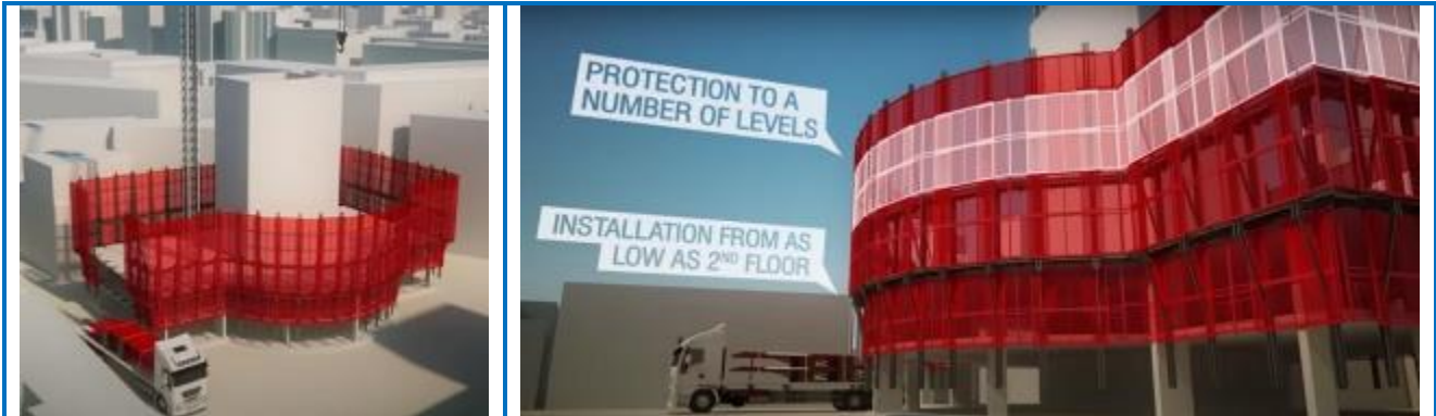
Figura 4.2.1.4: Pantalla de protección trepante - Fuente: SAFESCREEN from Hünnebeck
