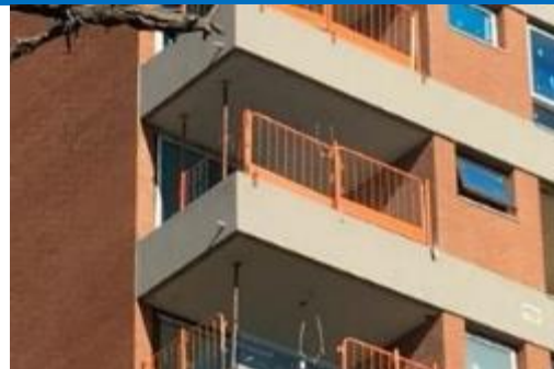
Figura 3.3.3.4: Baranda de marco metálico y malla de alambre acoplada al elemento de hormigón
