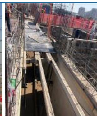
Figura 3.3.2.4: Colocación de encofrado (vigas y placa)
