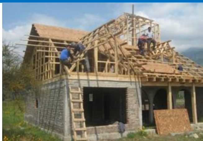
Figura 3.3.1.6: Estructura de albañilería confinada con segundo piso estructura de madera
