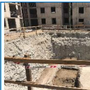
Figura 3.3.2.2: Borde de excavación
