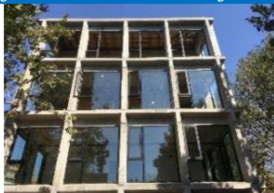
Figura 3.3.1.4: Estructura de hormigón revestida con ventanales
