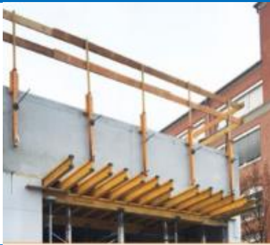
Figura 3.3.3.1: Baranda mixta con elementos de madera anclada al muro de coronación
