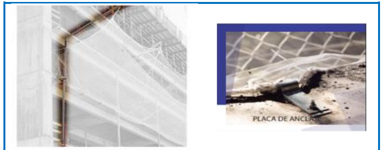
Figura 4.2.1.2: Red de contención HEKO con detalle de anclaje
