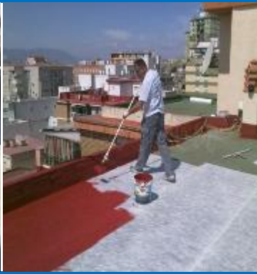
Figura 3.3.2.8: Colocación de impermeabilización
