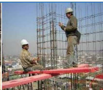
Figura 3.3.2.3: Enfierraduras de muros
