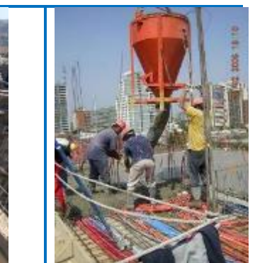
Figura 3.3.2.5: Hormigonado de losas
