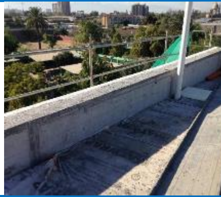
Figura 3.3.2.7: Colocación de cubierta
