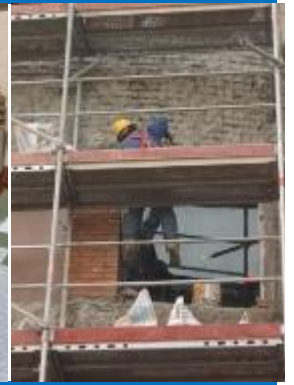
Figura 3.3.2.9: Ejecución de revestimientos exterior (enchape u otros)
