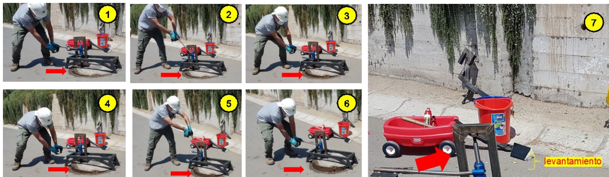
Imagen 25: Secuencia de desagripado exitoso, con aplicación de agua y raspaje de material
